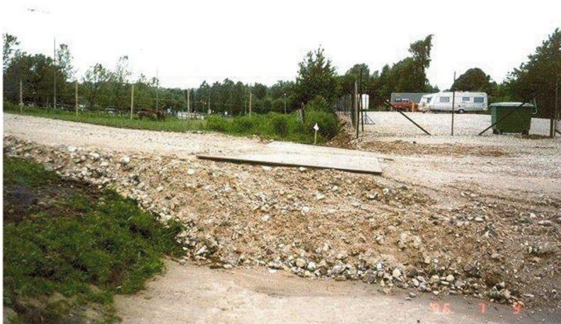
Overkørsel på tværs af 19 bar gasfordelingsledning
